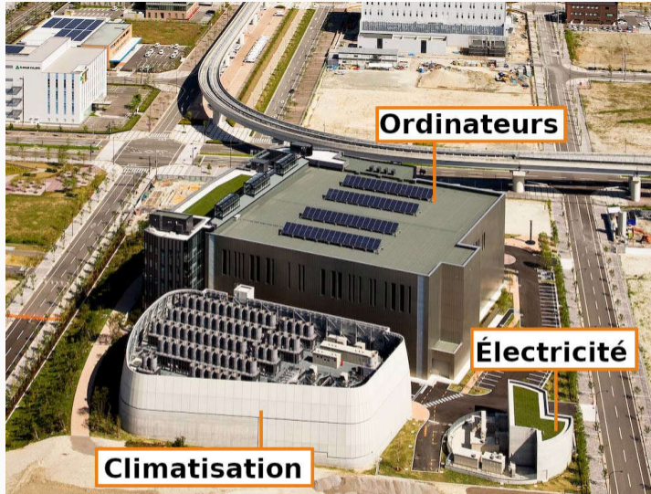
Le bâtiment du supercalculateur Fugaku
